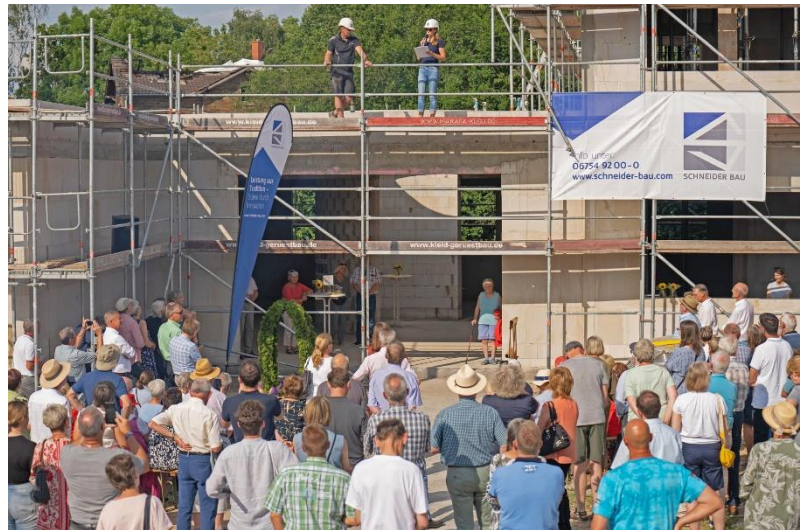
Über 250 Gäste feierten das Richtfest des Palliativzentrums Rheinessen in Eppelsheim
